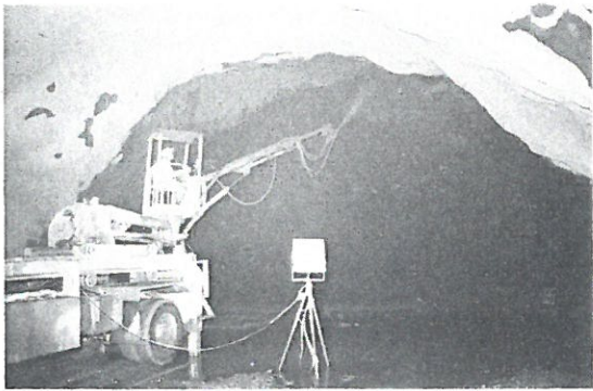
Sprøytebetong som arbeidssikring
