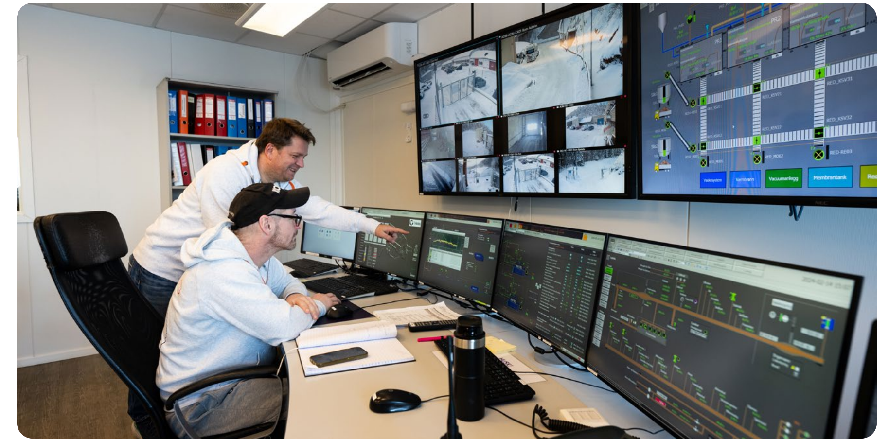
I kontrollrommet styres hele Veas-anlegget, og prosessene overvåkes av våre dyktige operatører.
