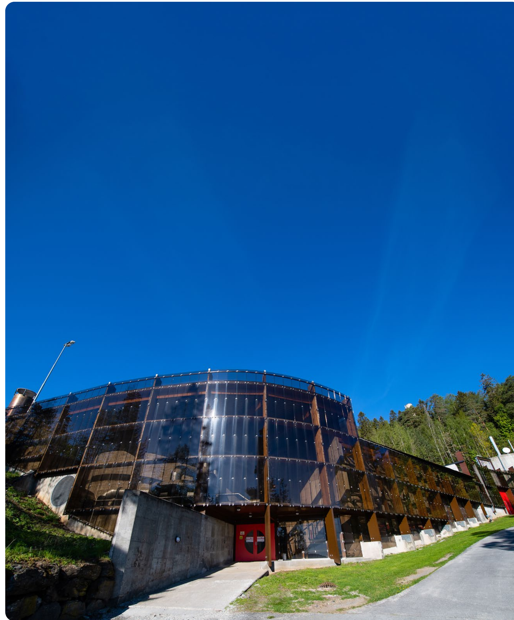
Bak denne glassfasaden ligger de fire bioreaktorene der avløpsslam omdannes til biogass.
