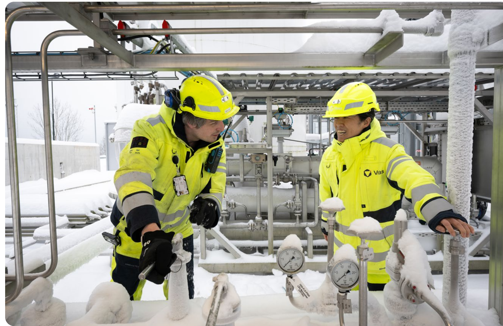
I raffineringsanlegget for biogass kjøles gassen ned slik at den blir til flytende biogass (LBG) som kan brukes i tyngre kjøretøy som lastebiler og busser.
