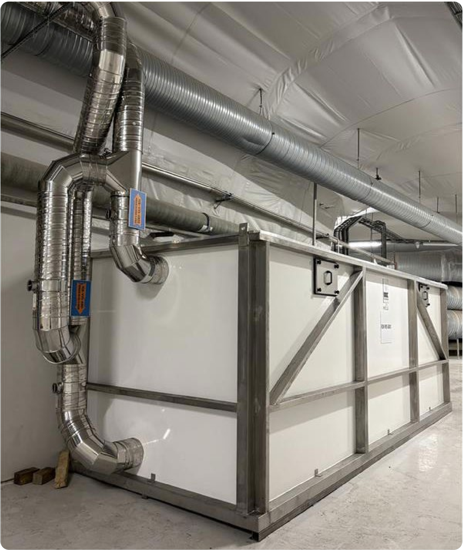
I mars 2025 ble et biofilter i tilknytning til foravvaningen satt i drift. Dette prosessavsnittet bidrar til utslipp av lukt, og biofilterets effekt vil bli evaluert etter noen måneders drift.
