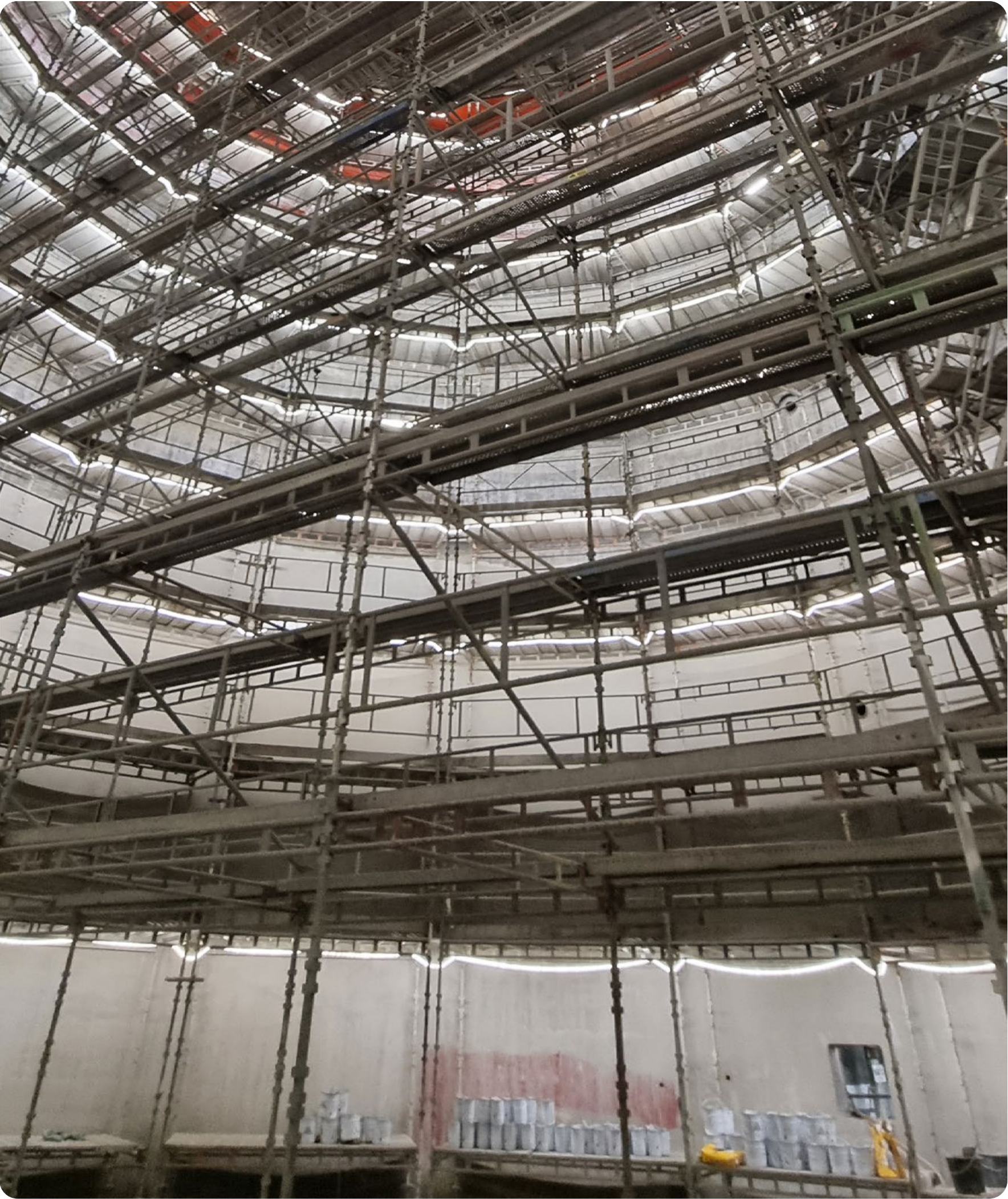
Rehabiliteringen av utråtningstankene går etter planen. I disse tankene blir slam til biogass i løpet av 21 dager. To av fire tanker er nå ferdige og satt i drift igjen. Den tredje tanken renoveres i andre kvartal 2025.
