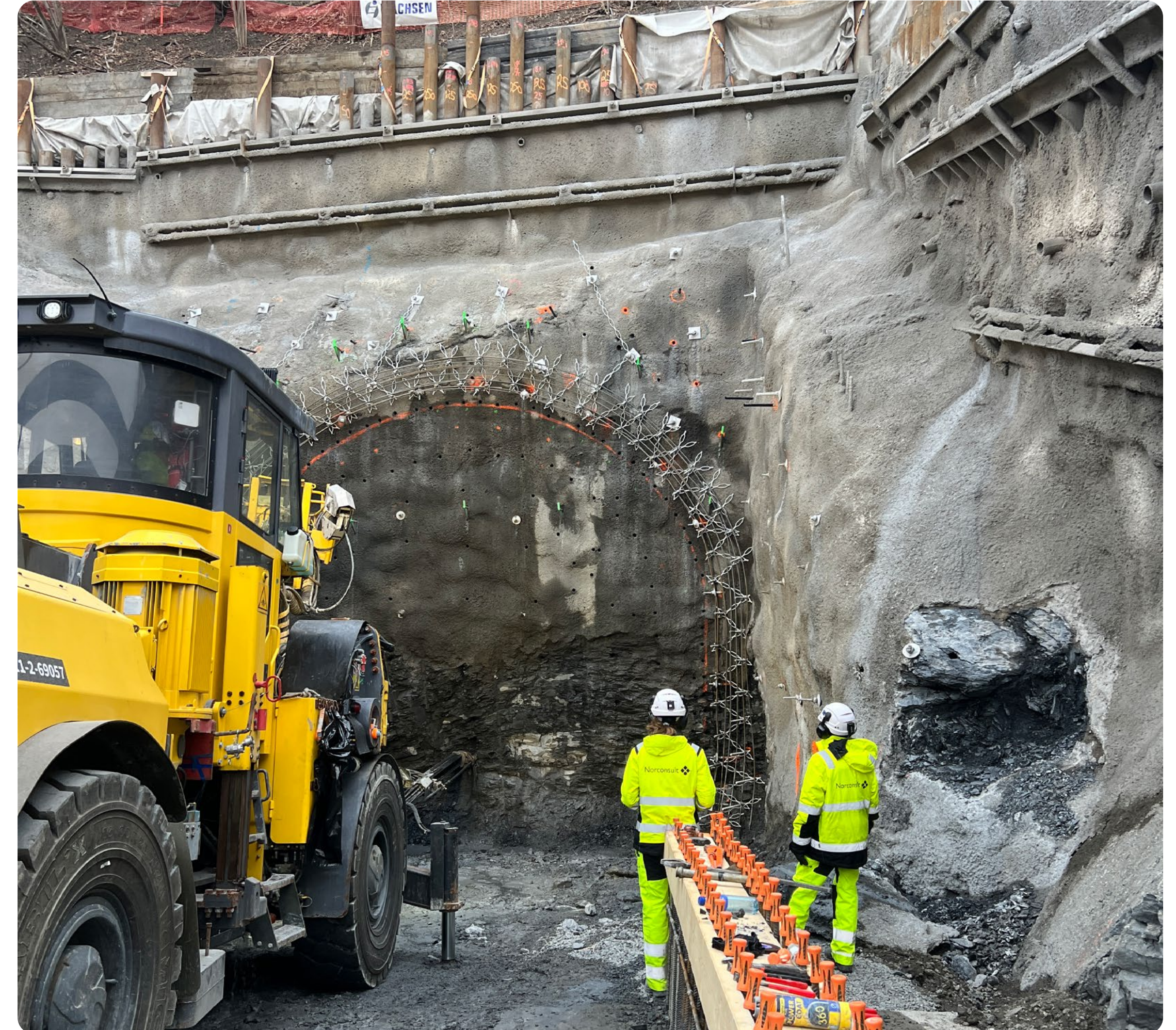
I næringsparken pågår sprengningsarbeidene for fullt. Den nye tunnelen vil gi direkte atkomst til fjellanlegget. Foto: Jostein Sindsen/Norconsult.
