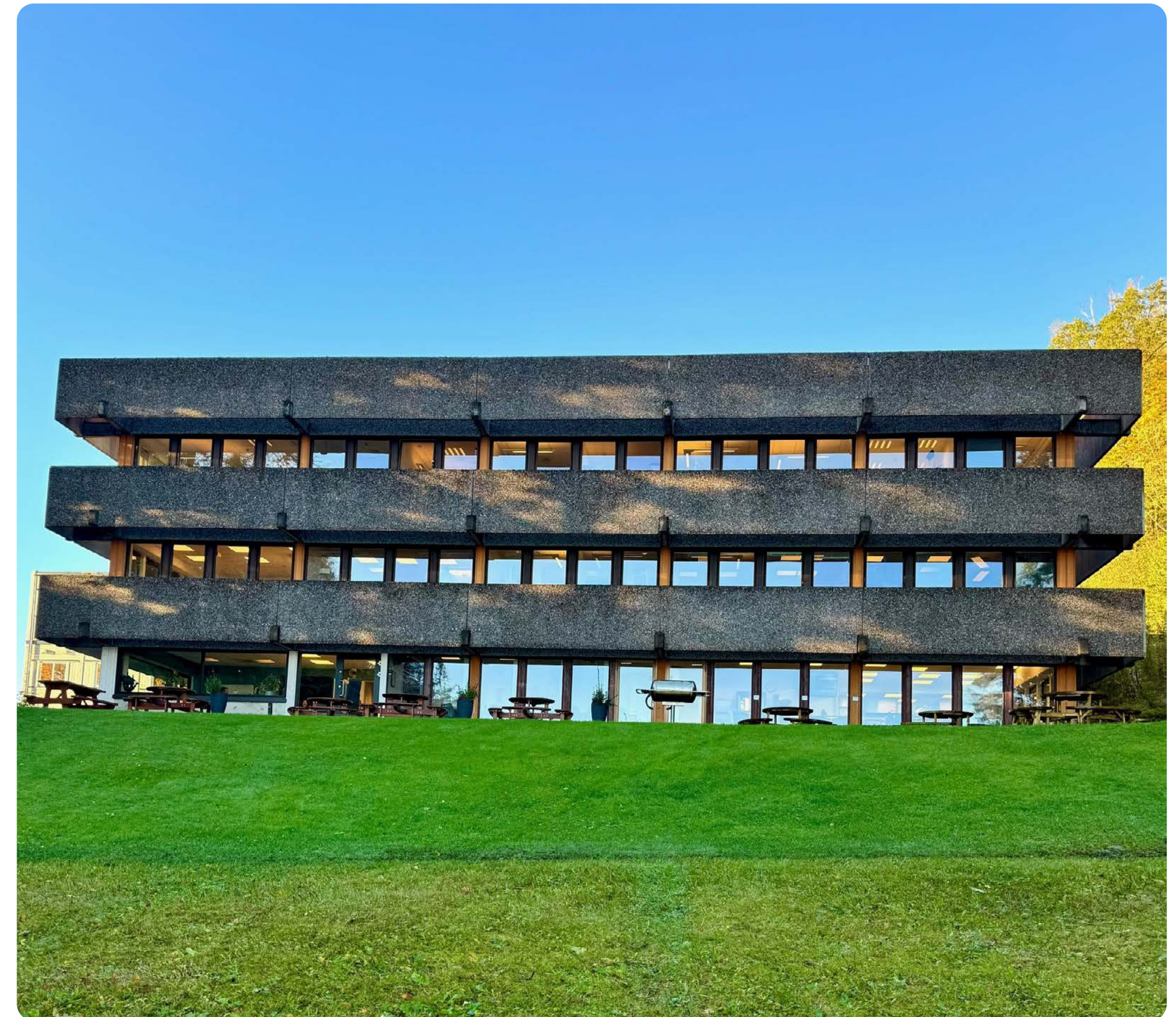
Administrasjonsbygget fra 1982 skal rehabiliteres. I tillegg vil det bli bygd to nye etasjer på det opprinnelige bygget.
