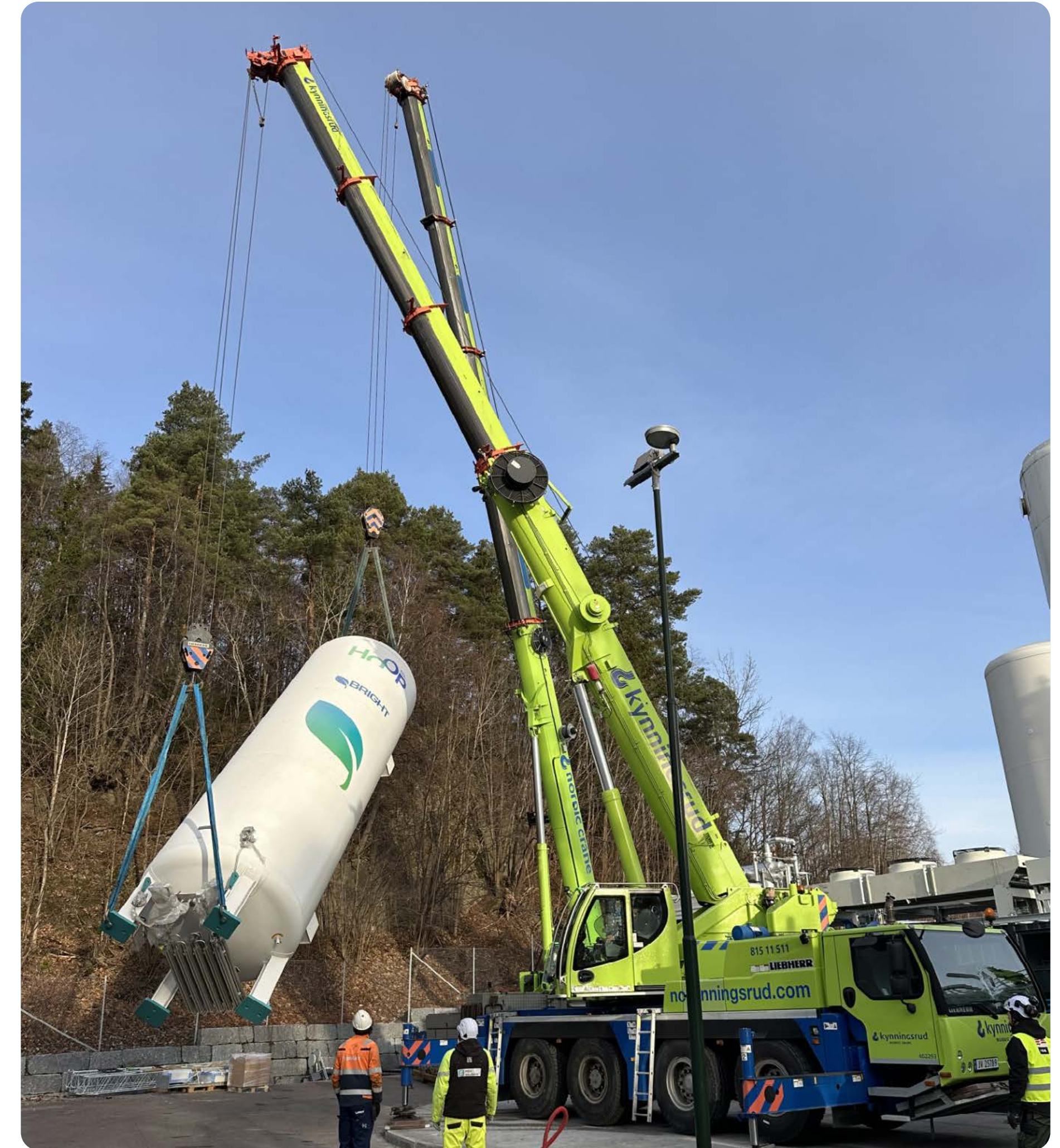
Raffineringsanlegget for CO 2 under oppføring i næringsparken ved siden av biogassanlegget.
