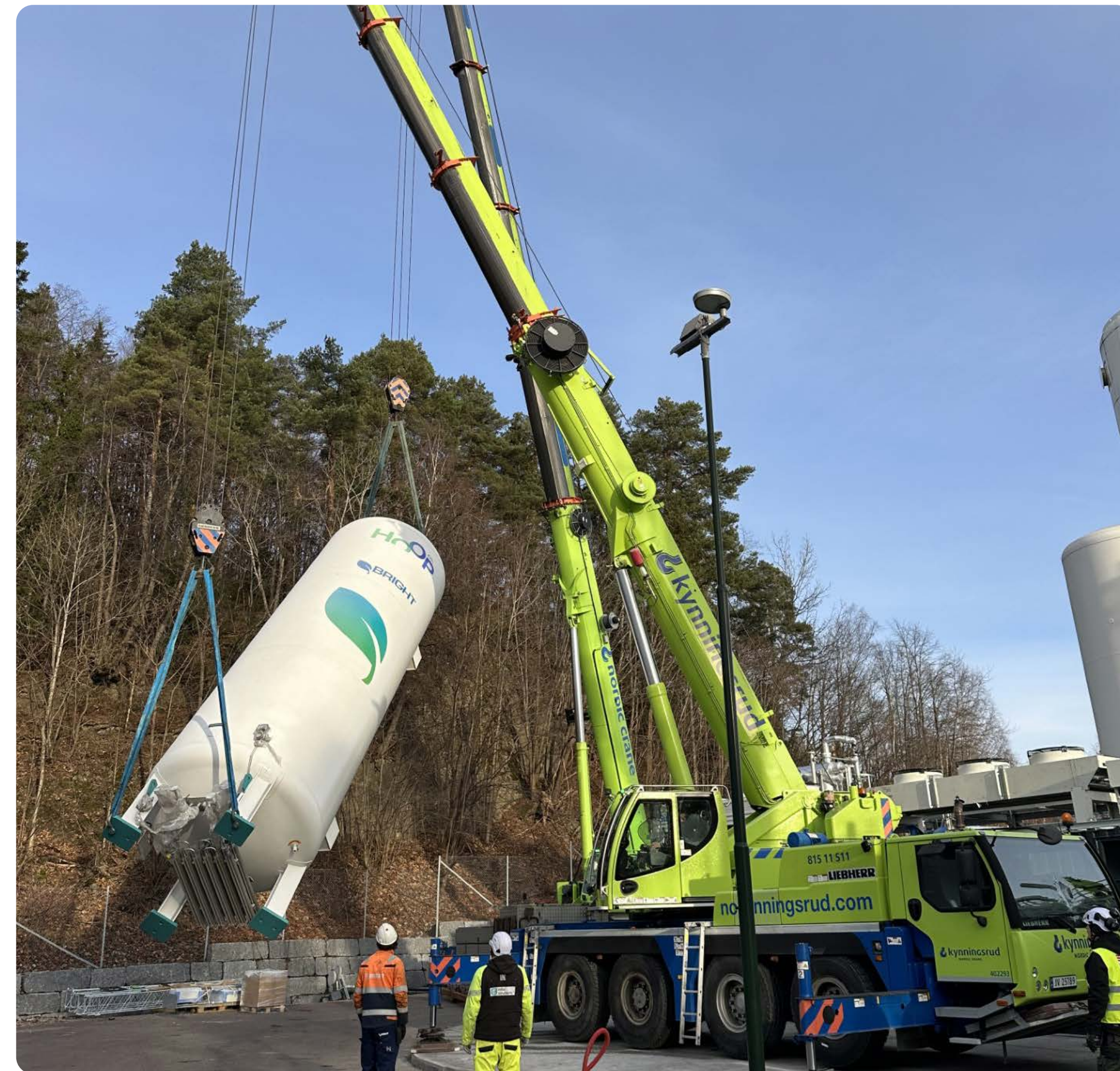
CO 2 -anlegget under oppføring. Hoop CO 2 produserte de første to tonnene flytende biogen CO 2 i januar. I februar gikk første eksportleveranse til Nederland.
